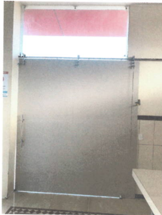
Imagen 4. Puerta de madera provisional.
